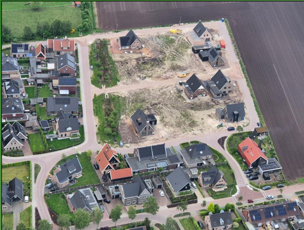
Nieuwbouw Marienberg (De Marke III)
